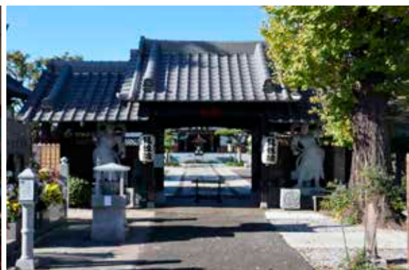
令和5年に改修落慶した山門
