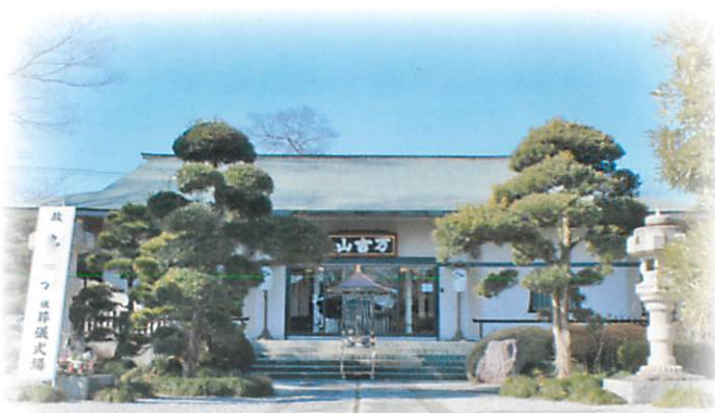
冷暖房を完備した近代的な本堂
